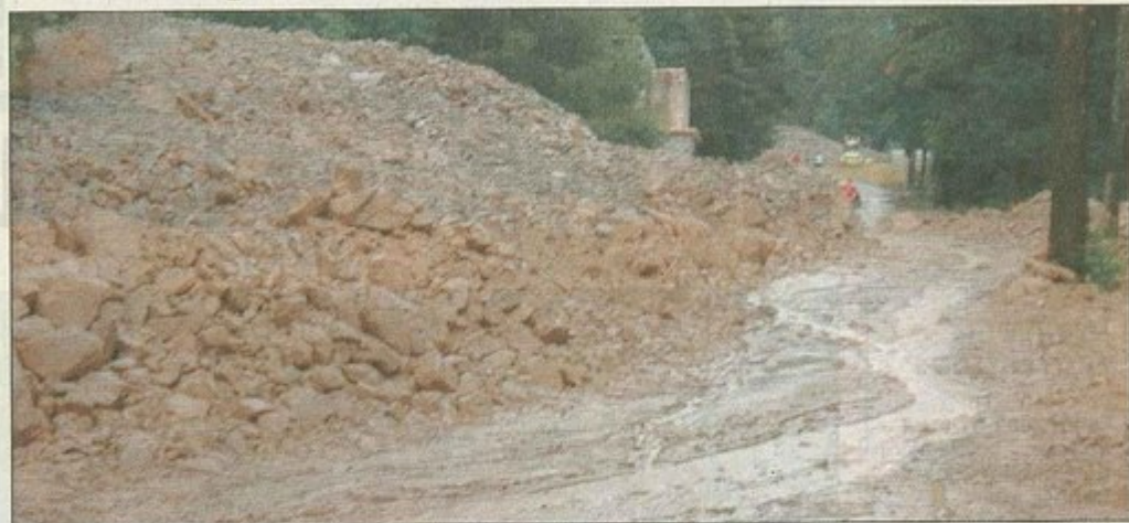
Par endroits, la RD 94 a été recouverte par des coulées de boue qui ont parfois atteint cinq mètres de hauteur.
